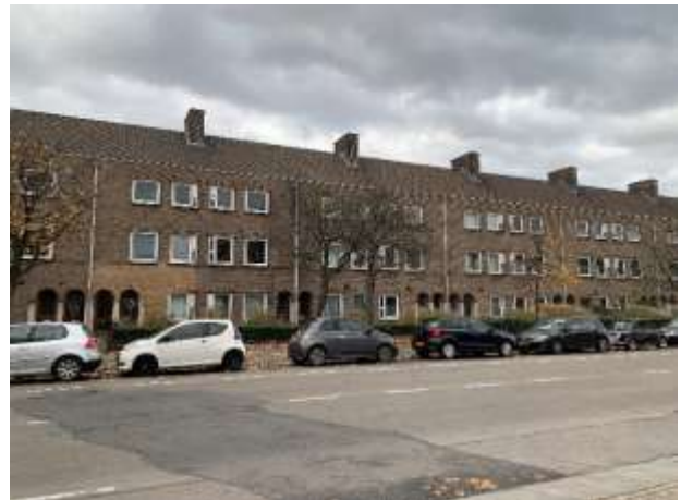
Bouwblok 1: het bouwblok waar komende week (medio februari) de werkzaamheden voor de sloop gaan starten
